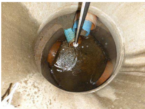
Figur 11: Brønd 1 mod nord.
