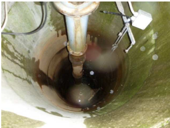
Figur 14: Brønd 5 ved pumpegraven
